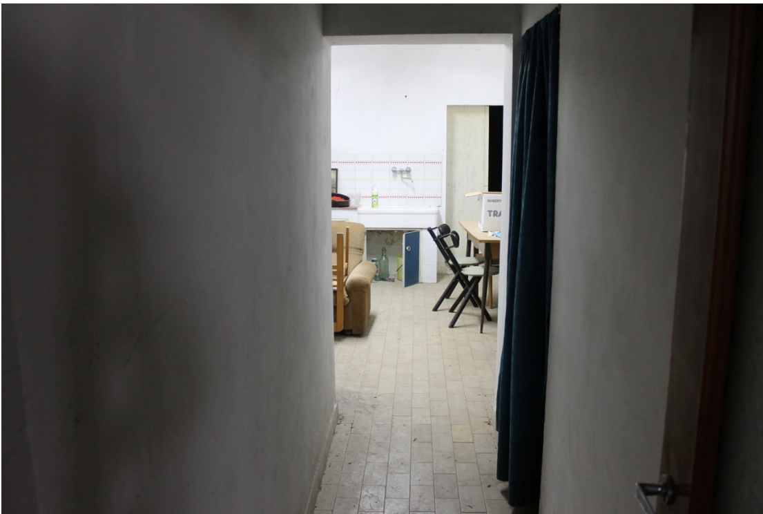
Corridoio cantine PS1
