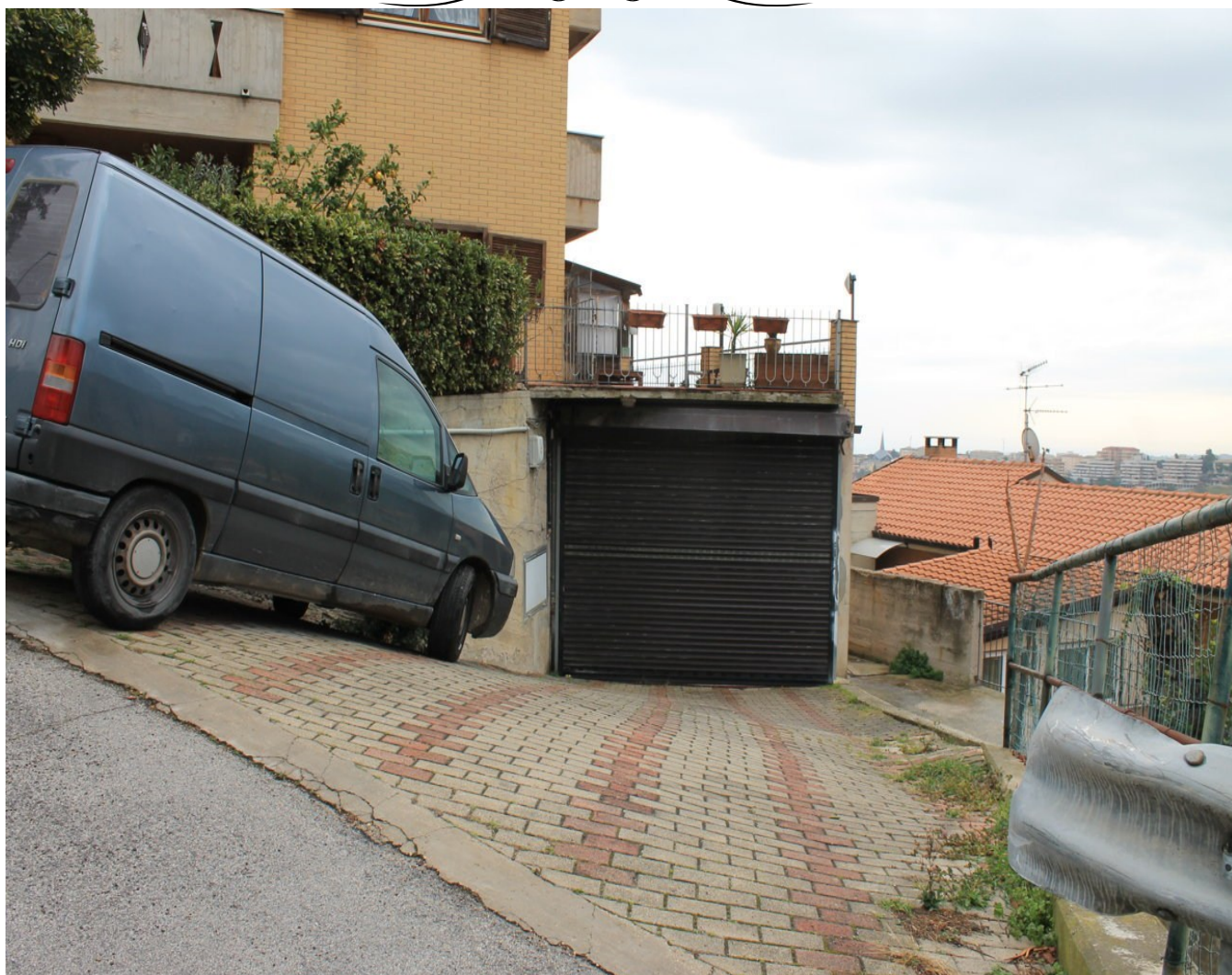
Garage e rampa di accesso
